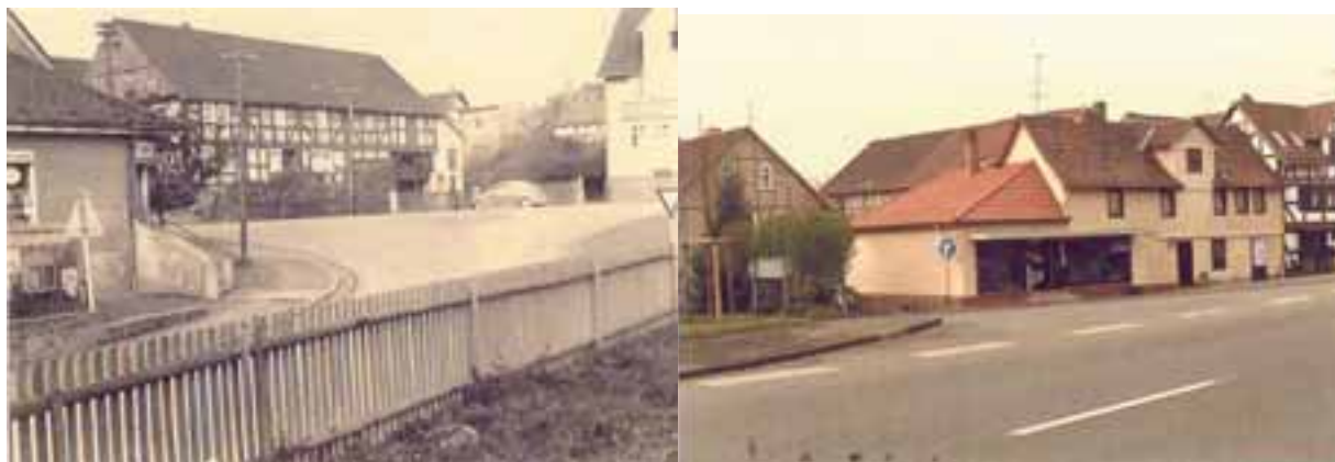
Abb. 4.1a Das Haus der Heilbrunns in der Bahnhofstraße früher (li) und heute 38
